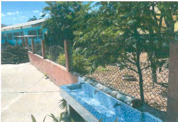
Foto 3: Remozar la malla del muro perimetral porque no esta en buenas condiciones.
